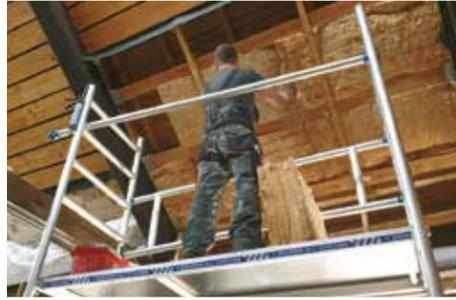
Nachdem Marder seit längerer Zeit das Dach des Tennisheimes bewohnt und die Isolierung vollkommen zerstört haben, nutzte die TGN den Lockdown im Frühjahr und isolierte das Dach im Saal komplett neu. Das Dach wurde mit einer 20 cm dicken Isolierung gedämmt und die Rolladenkästen wurden mit einem bissfesten Gitter gesichert. Die Firma K & S, Sebastian Krazyński aus Waldthurn, arbeitete hervorragend und benötigte nur vier Tage. Leider musste auch ein kaputter Rollladen ausgetauscht werden.
