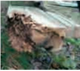
Zufällig wurde beim 20 Jahre alten Dach die massive Schädigung der Pfetten entdeckt. Alle Pfetten wurden erneuert und ein 120 mm Thermodach aufgesetzt. Insgesamt musste die Halle nur an sieben Tagen komplett gesperrt werden. Die Firma Holzbau Koller, Schirmitz, leistete unter schwierigsten Bedingungen hervorragende Arbeit. Nähere Infos unter [www.tg-neunkirchen.de](http://www.tg-neunkirchen.de)
